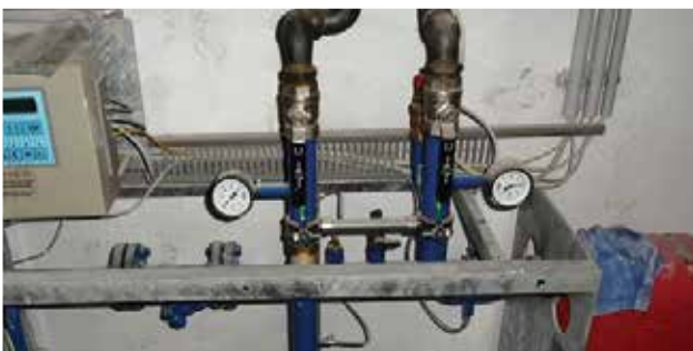
Wartungs- und Instandsetzungsarbeiten durch erfahrene Professionisten
